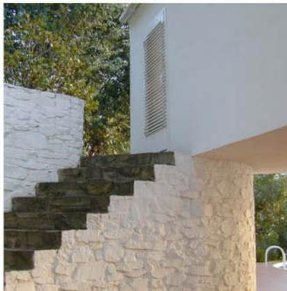
Abb. 29 - Auflager des Schlafzimmers auf der Stützmauer zum Hang
