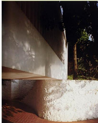
Abb. 18 - Blick von der Terrasse auf den Auflagepunkt des Schlafzimmerbereiches auf der Stützmauer gegen den Hang
