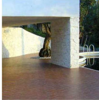
Abb. 27 - Auflager des Schlafzimmers auf der Stützmauer zum Pool
